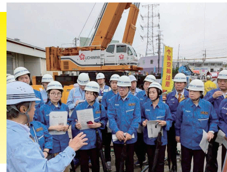
八潮市道路陥没現場を視察しました。
